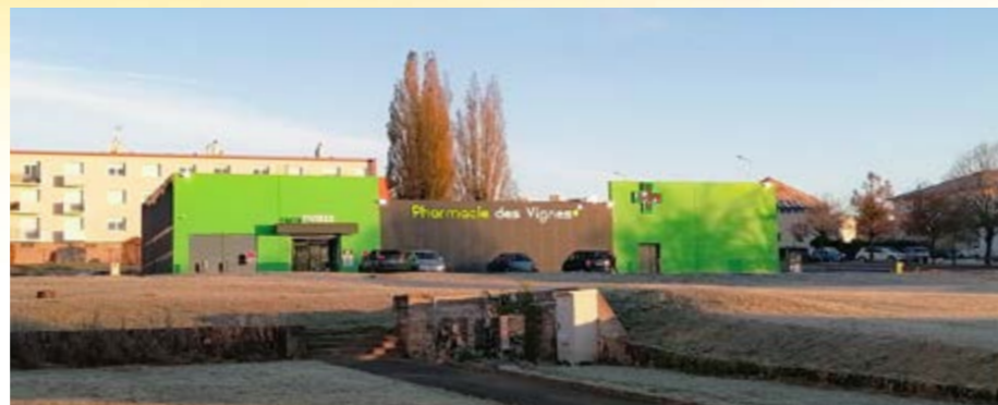
▲ Pharmacie des Vignes : projet privé qui modifie l'environnement de l'espace intermédiaire de la Ville.
