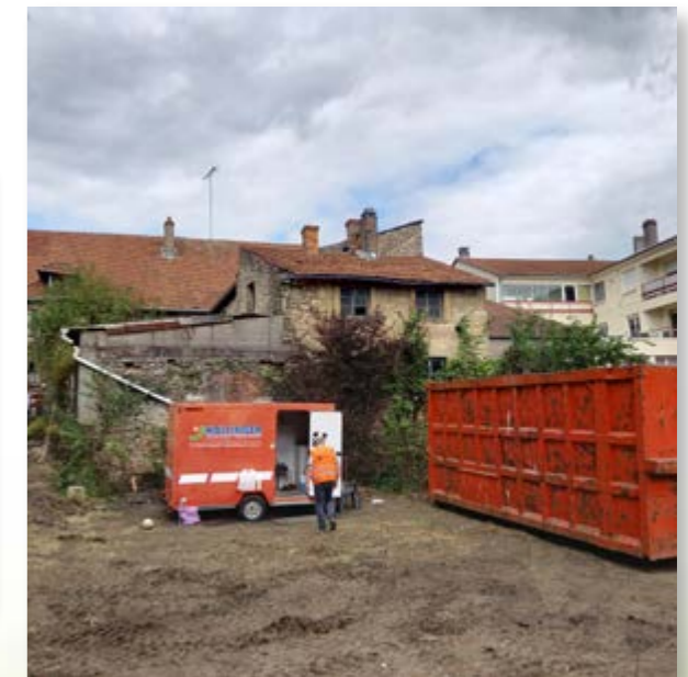
▲ Début des travaux de démolition de l'immeuble LOEB rue de Metz
