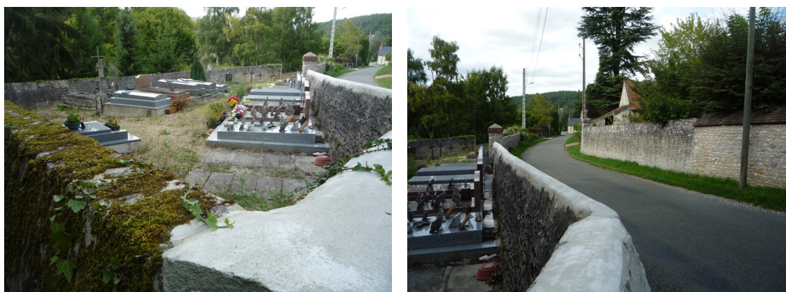
Source : Photos J-P DENUC. Les murs du cimetière
