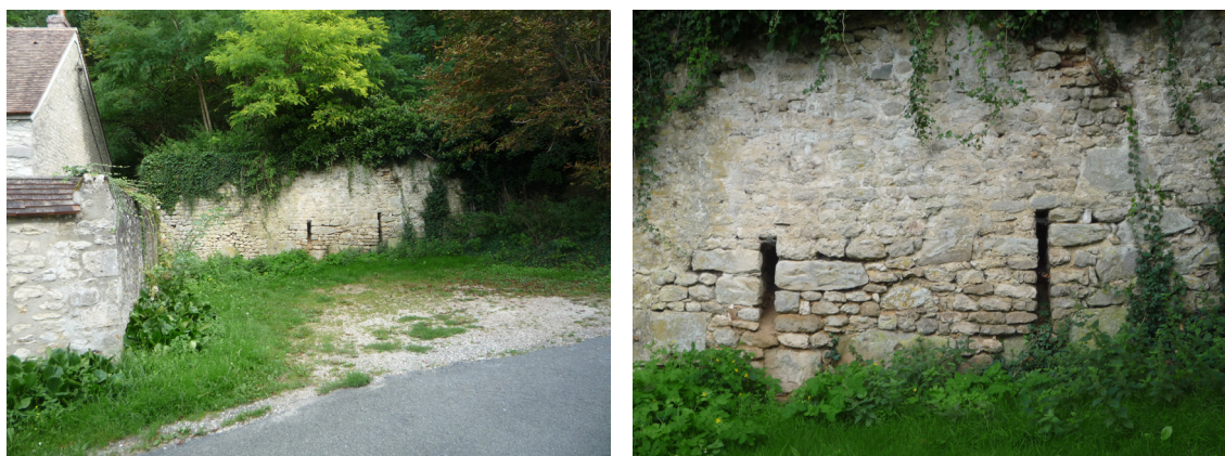
Source : Photos J-P DENUC. Les vestiges du château
