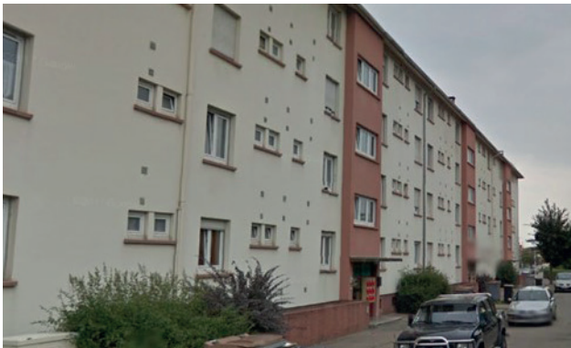
Rue Sobieski – réhabilitation du bâtiment C
