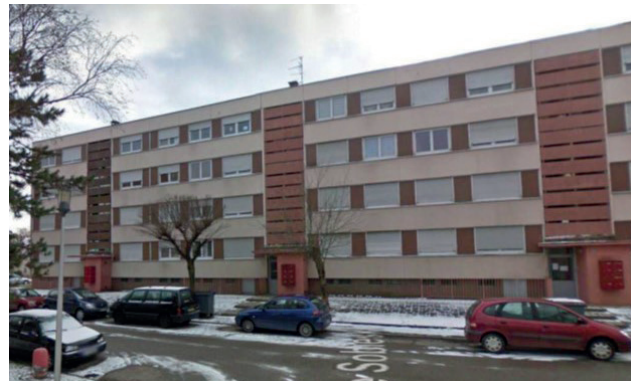
Rue Victor Hugo – démolition du bâtiment B avant reconstruction
