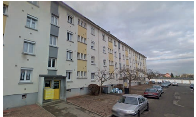
Rue Sobieski – réhabilitation du bâtiment A
