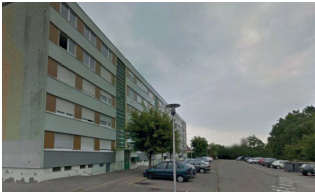
Rue Saint-Exupéry – démolition du bâtiment D avant reconstruction
