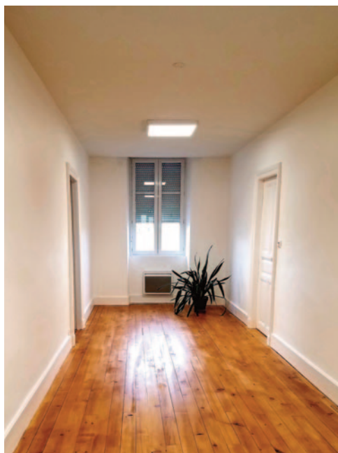
Travaux mairie, couloir bureau conseillers et nouvelles archives
