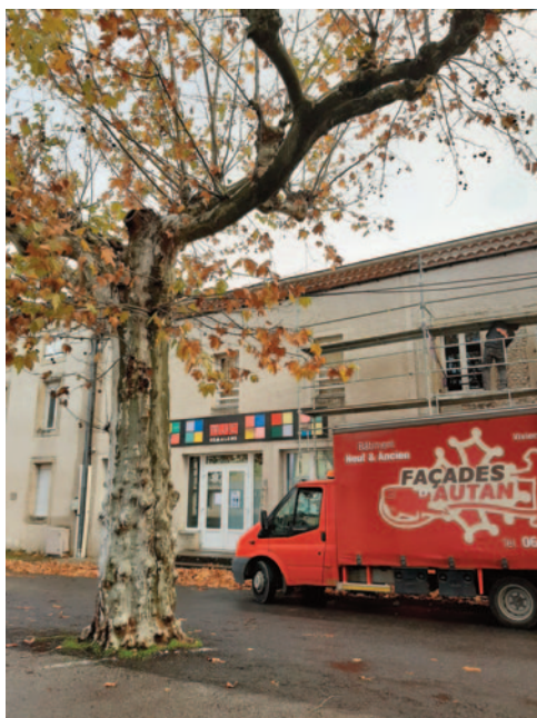
Début des travaux
