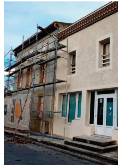
Réfection des façades
