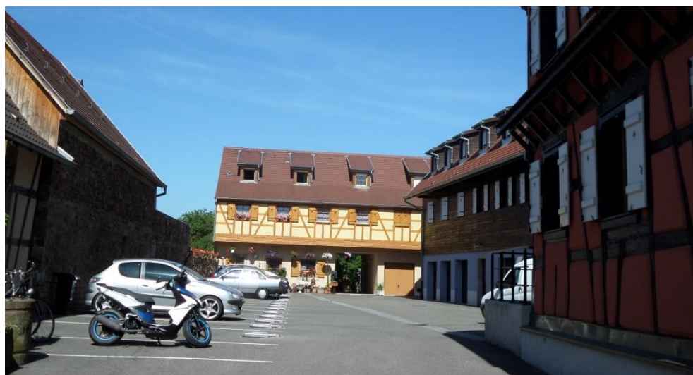
Exemple de réhabilitation de bâti en logements collectifs
