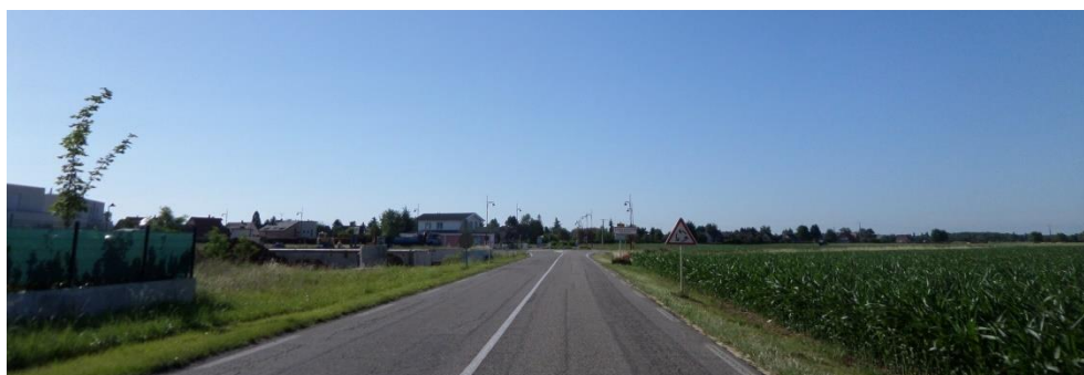
Entrée Nord-Ouest depuis Colmar
