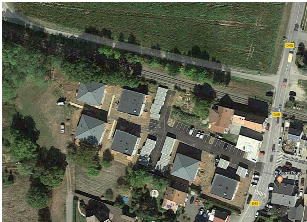
La nouvelle opération de logement intermédiaire rue de la Gare
