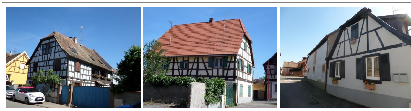
Exemples d'habitations en centre ancien
