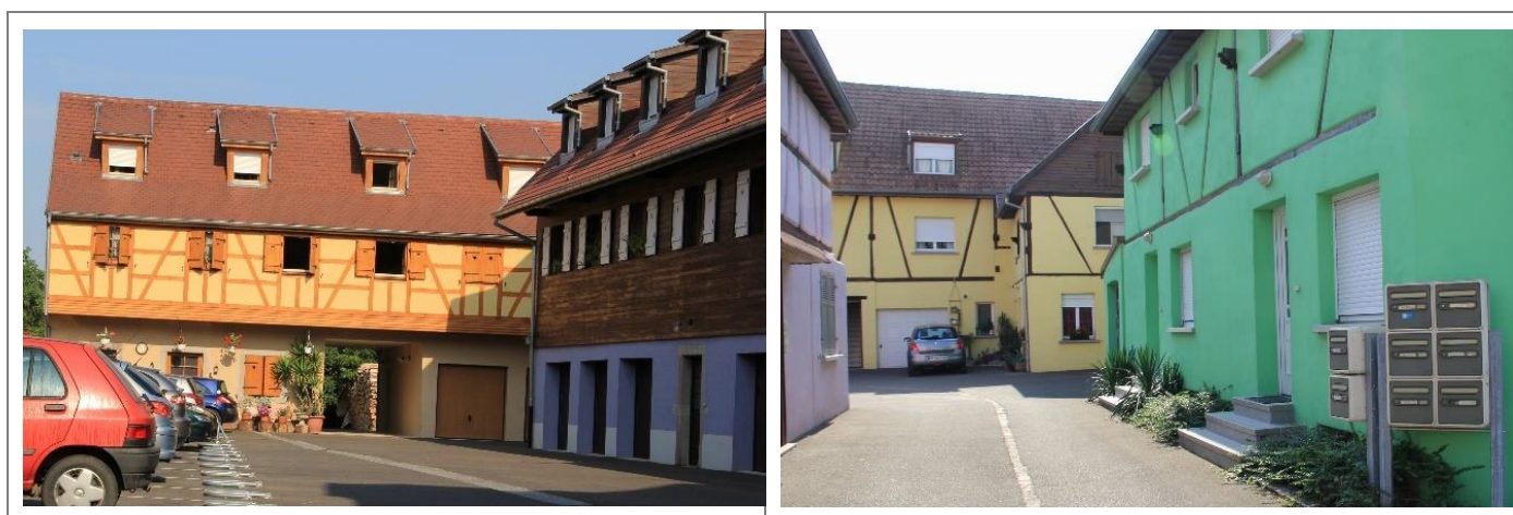
Exemple de réhabilitation de bâtiments en centre ancien en logements collectifs
