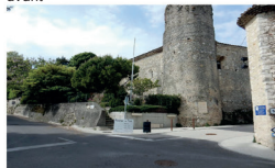
VUE DU SITE AVANT TRAVAUX
