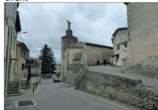
VUE DU SITE AVANT TRAVAUX
