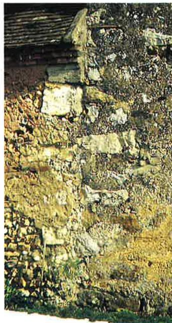
La majorité des maisons sont construites en moellons de pierre. Les angles et l'entourage des baies sont chaînés par des appareillages de brique ou parfois de pierre de taille. Le moellon est enduit, laissant la pierre de taille ou la brique apparente.
