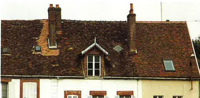
La lucarne, largement utilisée pour accéder au comble des petites exploitations, introduit un élément d'animation dans la façade.
