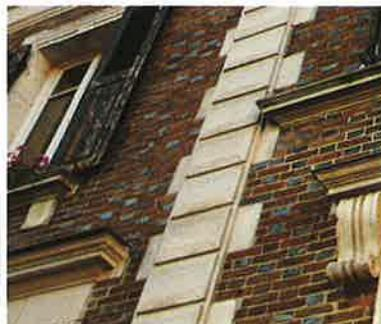
D'autre part les rangs de briques perpendiculaires peuvent être mis en saillie et créer des bandeaux et corniches.
