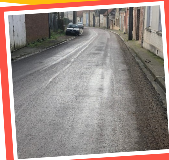
Réfection de l'enrobé rue Jules Ferry
