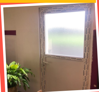
Remplacement d'une porte dans la classe de Mme Kowalkowski pour mieux l'isoler
