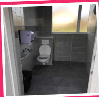
Création d'un WC PMR à l'école
