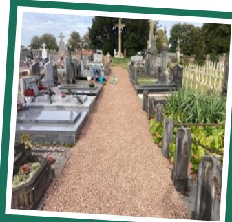
Réfection des allées du cimetière
