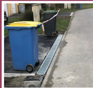
Drainage des eaux pluviales rue des Saules
