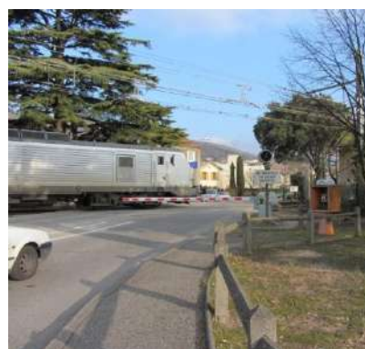
Passage à niveau RD 86E
