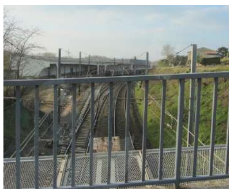
Pont rue des Gonnettes
