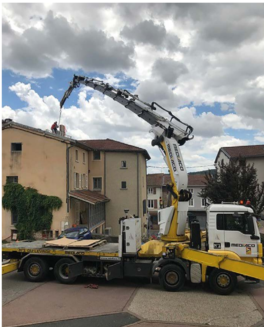
Logements Place de l'Eglise
