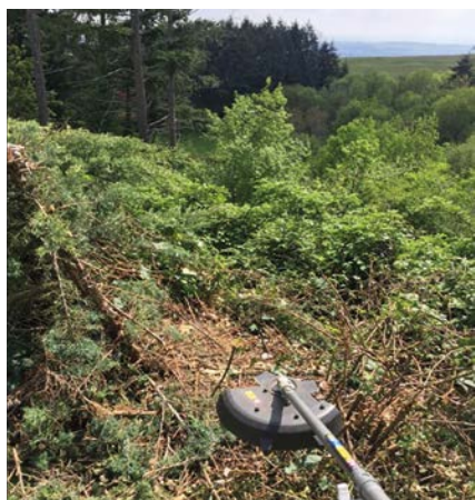
Début des travaux mai 2021
