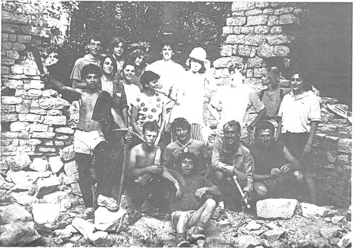
Le début de la lutte contre la disparition de notre patrimoine (chantier "Jeunesse et reconstruction" 1988 à Saint Médard d'en Haut)
