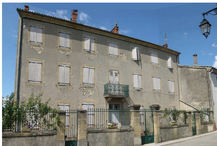
L'immeuble Chantebise vue Sud actuelle
