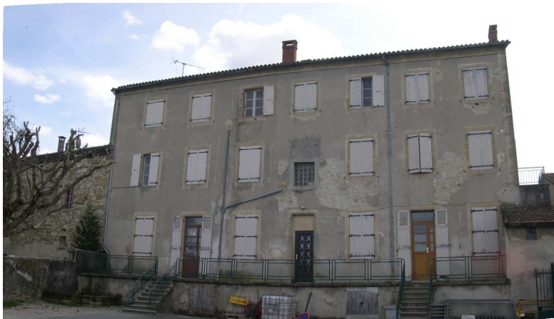
L'immeuble Chantebise vue Nord actuelle
