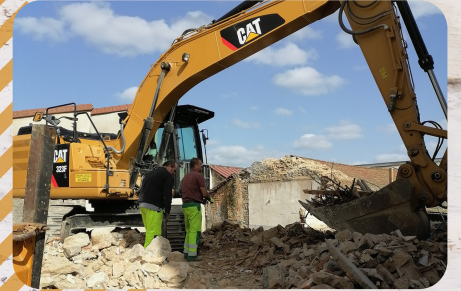
Réfection du mur de la maison Tassand
