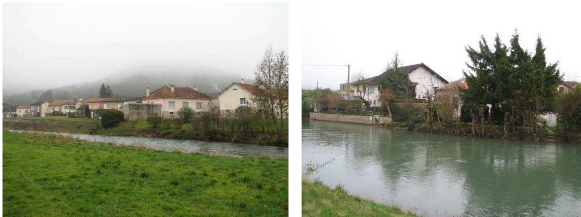
Zone d'urbanisation proche de l'Ornain
