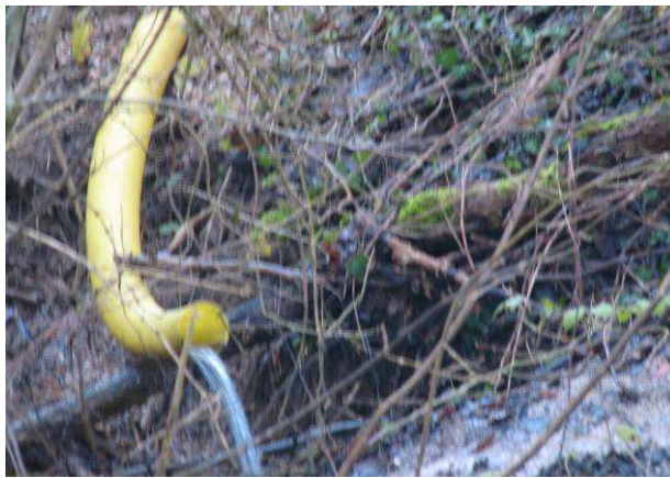
Drain s'écoulant directement dans le ruisseau de Resson
