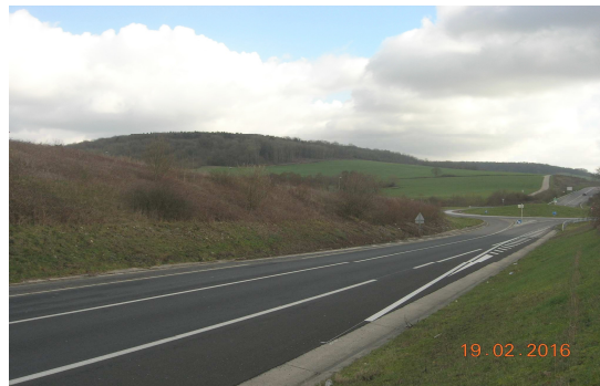
La RN 1135 en bordure de la zone 1AUx
