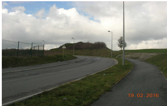
Voie d'accès et contre-voie liaison douce
