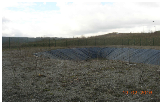
Bassin de rétention sur la zone 1AUx
