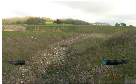
Noe pour la rétention eaux pluviales
