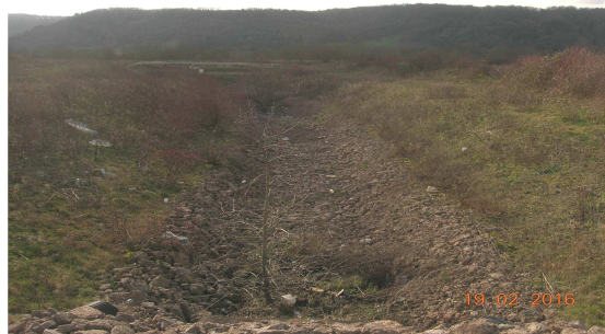
Noe pour la rétention eaux pluviales
