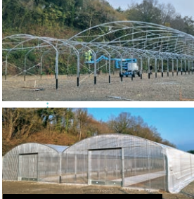
Le montage de la serre municipale a bien avancé
