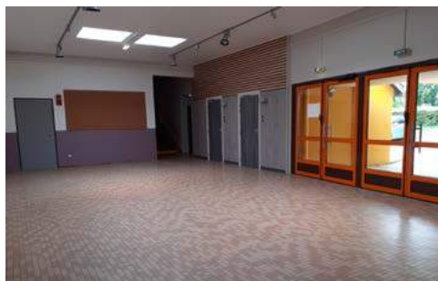
Rénovation du hall d'entrée
