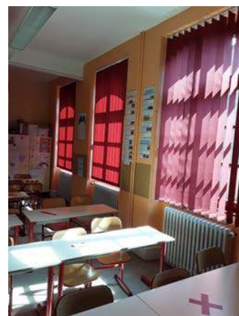
Installation de nouveaux stores à l'école primaire
