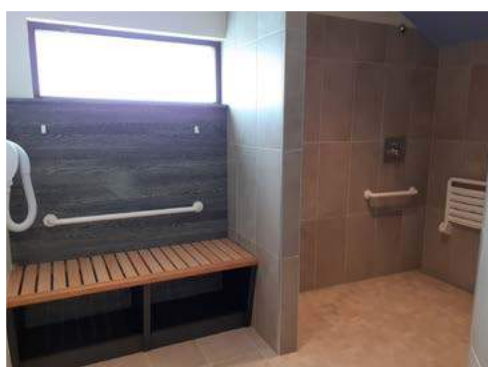
Fin des travaux de rénovation des sanitaires au Centre Socio-Culturel et Sportif et création de vestiaires-douches PMR
