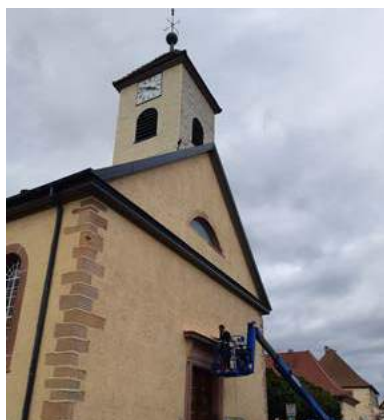
Habillage des planches de rives à l'église
