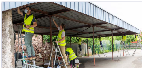
Peinture des poteaux à l'école élémentaire
