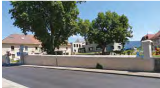
Réfection du mur d'enceinte du Parc Municipal
