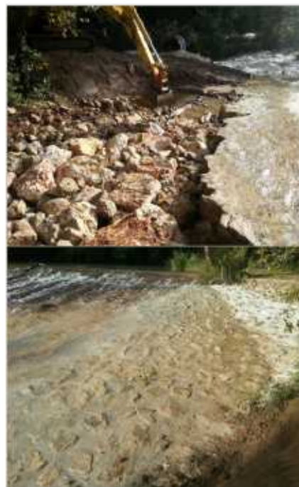
Rive gauche de l'écluse. En couverture du bulletin, vue de la fosse centrale avant et après.
