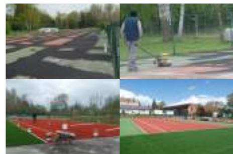
Des travaux longs et minutieux
