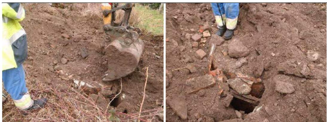
**Figure 1.15 Puits rebouché**
