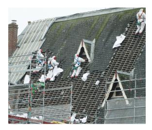
a réfection de la toiture de l'église se poursuit. Il reste à désamianter la partie basse côté nord et à poser les ardoises sur les parties basses. La deuxième partie des vitraux sera posée en septembre. Ces travaux s'accompagnent de réparations en profondeur des chéneaux et de la charpente intérieure, dont certaines parties étaient très dégradées.
