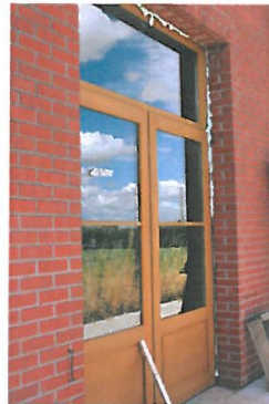
Nouvelles portes à l'arrière de la salle polyvalente.
