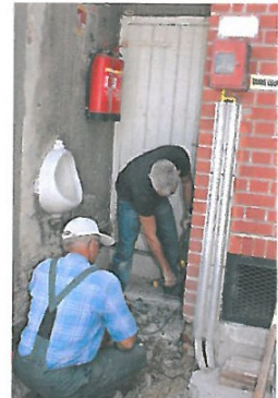
Installation d'un nouveau sanitaire qui sera ouvert au public
