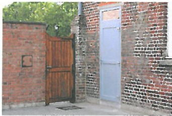
Dans la cour de l'école, porte remplacée
