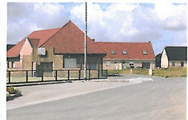
Parkings supplémentaires autour de la cantine et de l'école
