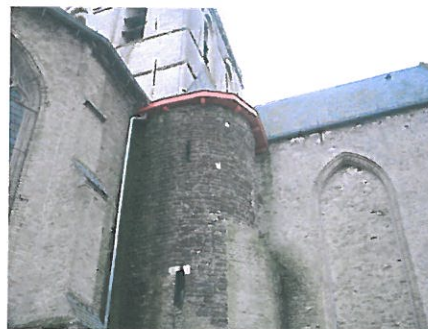
Réparation du chéneau
