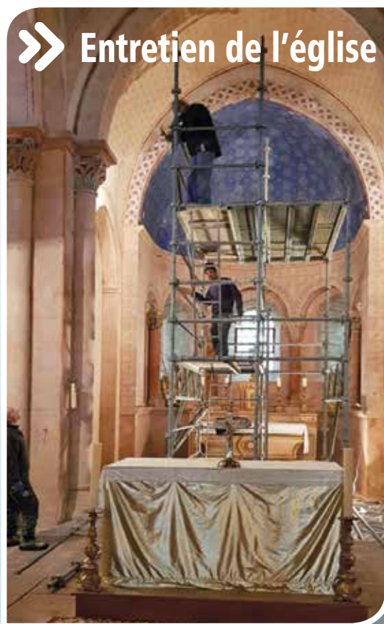
Après la réparation de la toiture et des écoulements des eaux en 2016-17, une réparation de l'arc du transept et des fissures apparues a été nécessaire.
