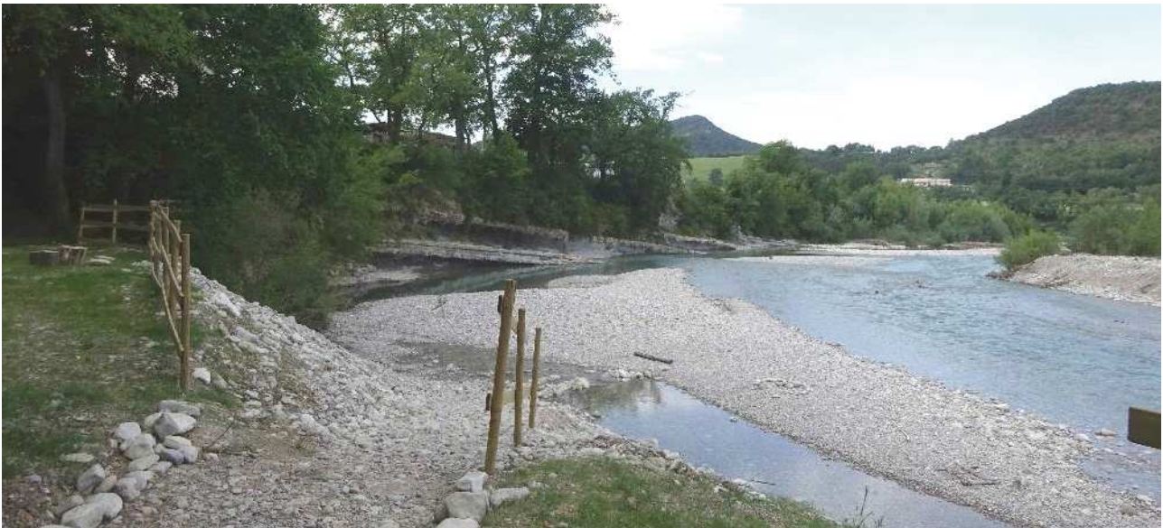
Accès à la berge de la Drôme depuis le camping
