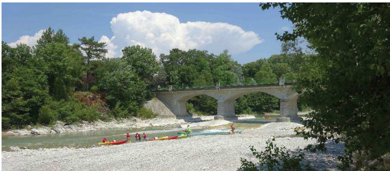
Vue de la rivière Drôme en aval du pont
