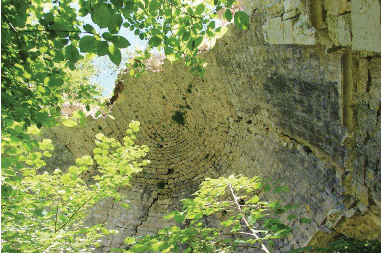
Ruines de l'ancienne église du monastère Saint-Médard – cliché 2016
