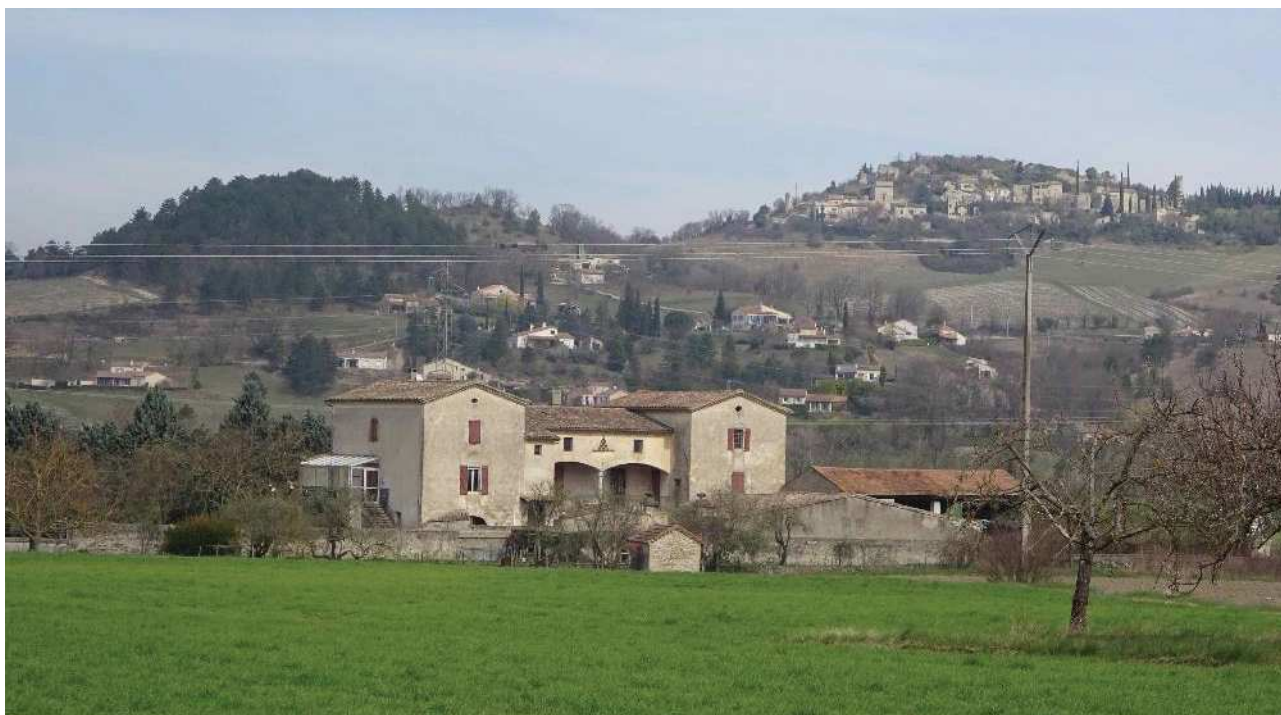
Ancienne ferme composée autour d'une cour, au nord du village de La Clastre (19 ème siècle) – photo 2017
