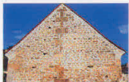
mur appareillé en pierre, harpes en pierre de taille et remplissage en moellon lié au mortier de chaux
