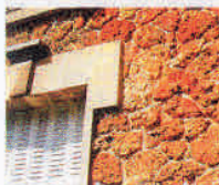
meulière avec joint creux au mortier bâtard
