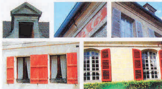
modénatures en pierre de taille : bandeau, corniche
