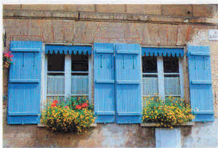
Pierre de taille avec joints à la chaux arasés au nu de la pierre
