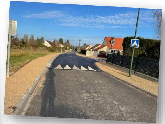
Création de marquage de stationnement au sol et réfection des trottoirs avec une finition en calcaire fin.
