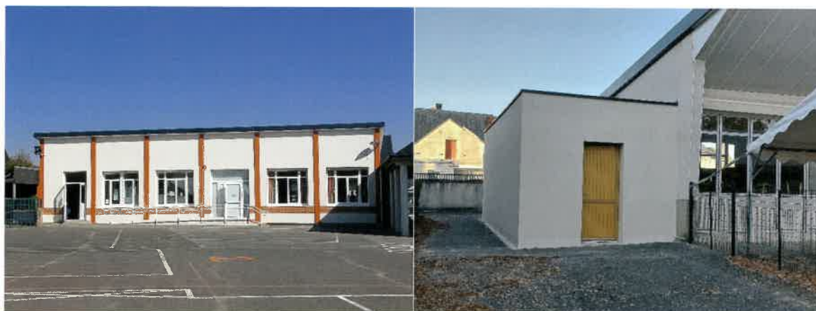
Rénovations des bâtiments scolaires et construction d'un local de rangement
