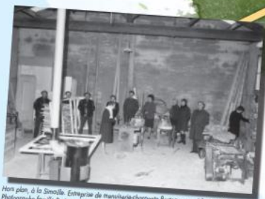
Atelier plan, à la Simaille. Entreprise de menuiserie-charpente Barreau, vers 1960-1970. Photographie famille Barreau.
