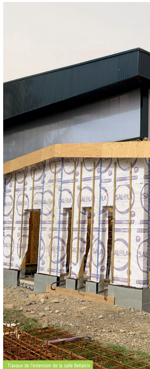
Travaux de l'extension de la salle Bellatrix
