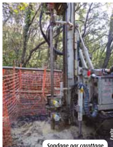
Sondage par carottage
