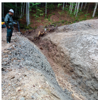
Fosse pour nouveau drain ovoïde
