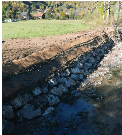
Berges du pont de Lémy (SM3A)
