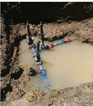
Remplacement des vannes de séparation dans le bas du village
