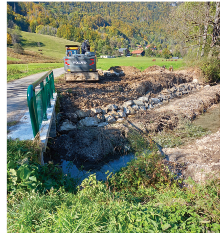
Travaux du pont de Lémy (SM3A)
