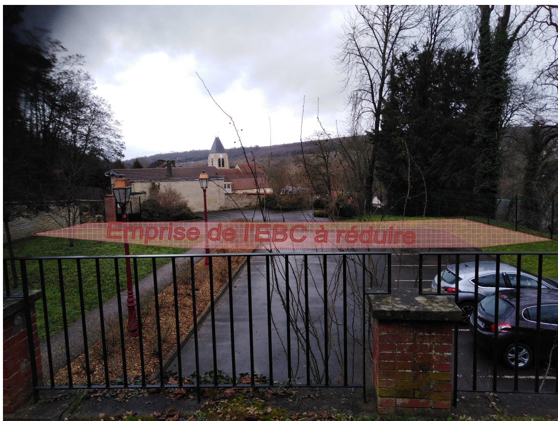
Vue du parking et du pignon nord de la maison Notre Dame, depuis l'extrémité nord de la parcelle Emprise de l'EBC
