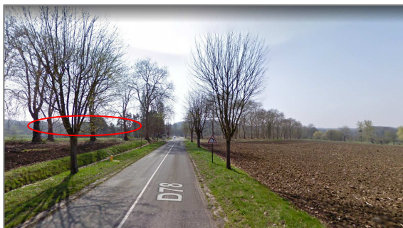
Vue du site depuis la RD78 au nord, en provenance de Beaumont-sur-Oise
