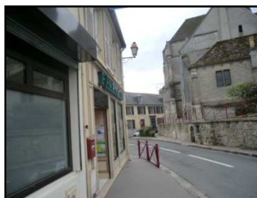
Vue fermée dans le centre urbain Rue Pierre Brossolette
