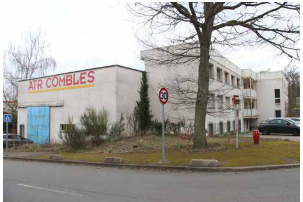
Le projet d'un pôle scolaire débute par la destruction de ce bâtiment acquis par la commune zone des Corroyés pour y construire les nouveaux locaux des services techniques.
