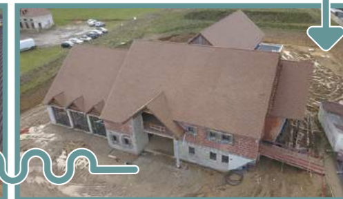
Finition de la couverture (Janvier 2021)
