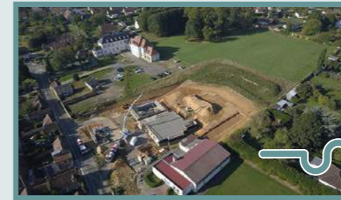
Coulage du plancher de la cantine (Septembre 2020)
