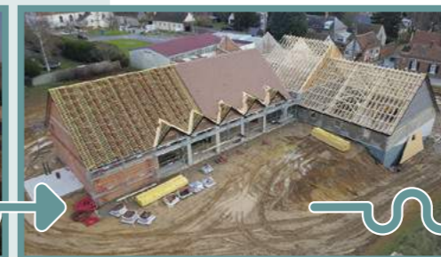
Couverture tuiles et étanchéité sur la terrasse toiture plate (Décembre 2020)
