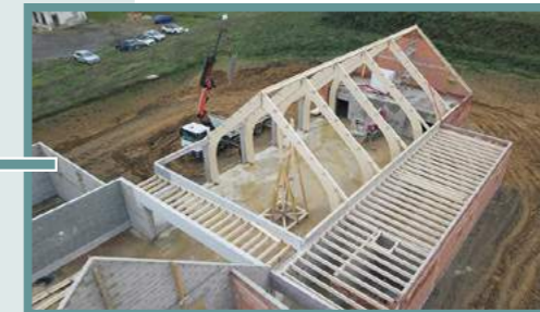
Levage de la charpente bois (Novembre 2020)
