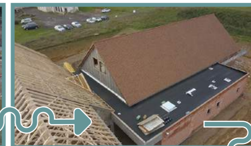
Couverture tuiles et étanchéité sur la terrasse toiture plate (Décembre 2020)
