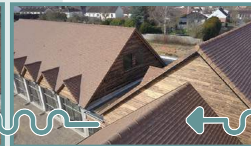
Menuiserie aluminium et bardage en bois (Mars 2021)
