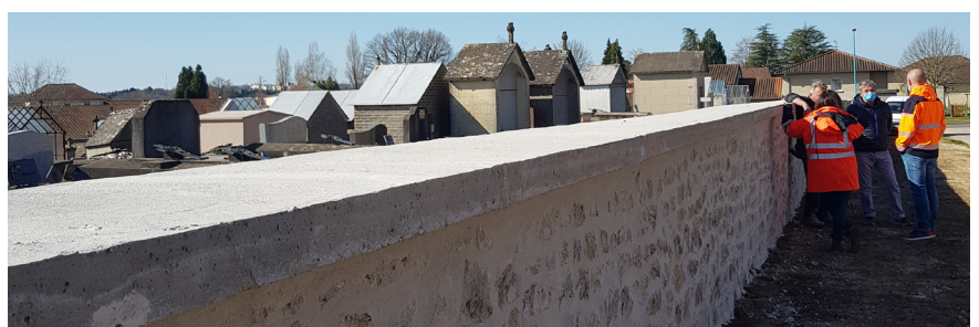
Réception des travaux le 29 mars dernier.
