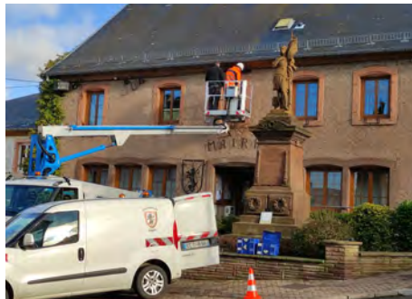
Installation des nouveaux éclairages festifs sur la façade de la mairie
