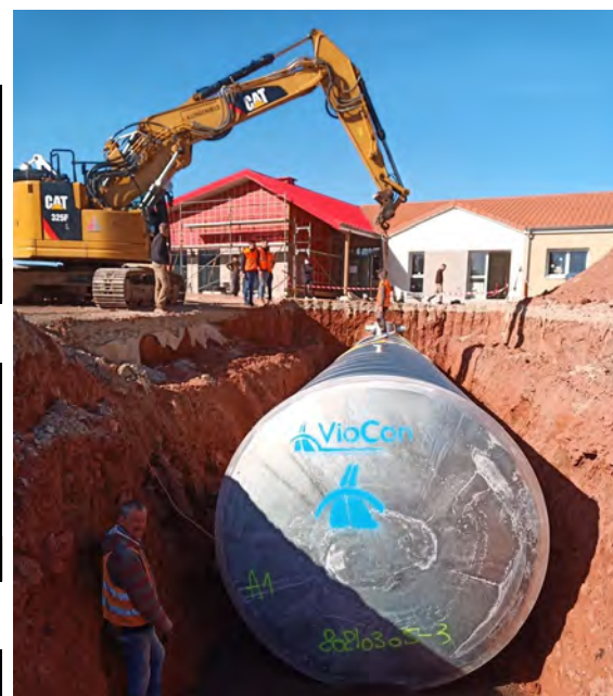
Installation de la réserve incendie de 120m 3 (le 29/03/2021).
