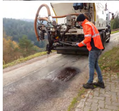
Mise en œuvre de la technique « blow patcher »
