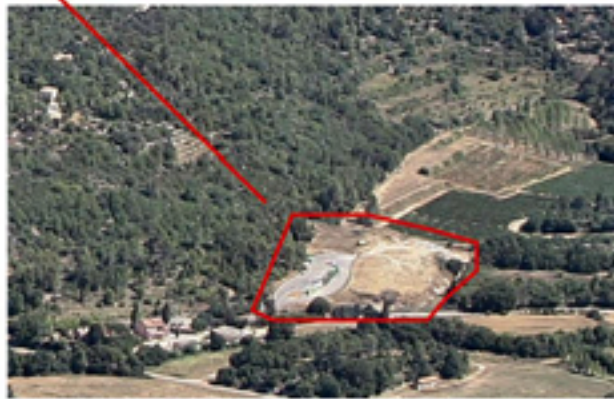
PLU DE BRAS DECHETTERIE ET ZONE NE (vues obliques de 2008)
