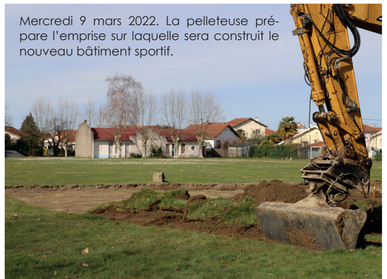
Lundi 14 mars 2022. Réunion de chantier avec Christelle MAZOUAT, Directrice des Services Techniques, et les entreprises qui interviennent, avec à leur droite une emprise au sol goudronnée.
