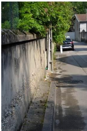
trottoir trop étroit dans une rue ancienne
