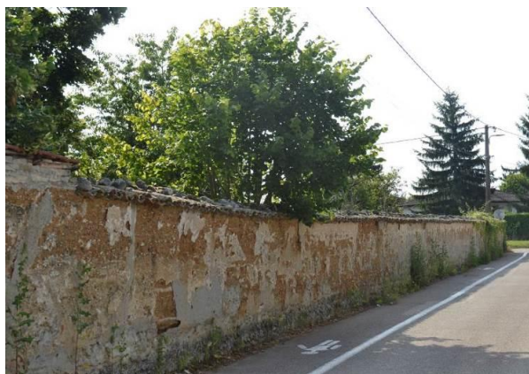
Mur en pisé
