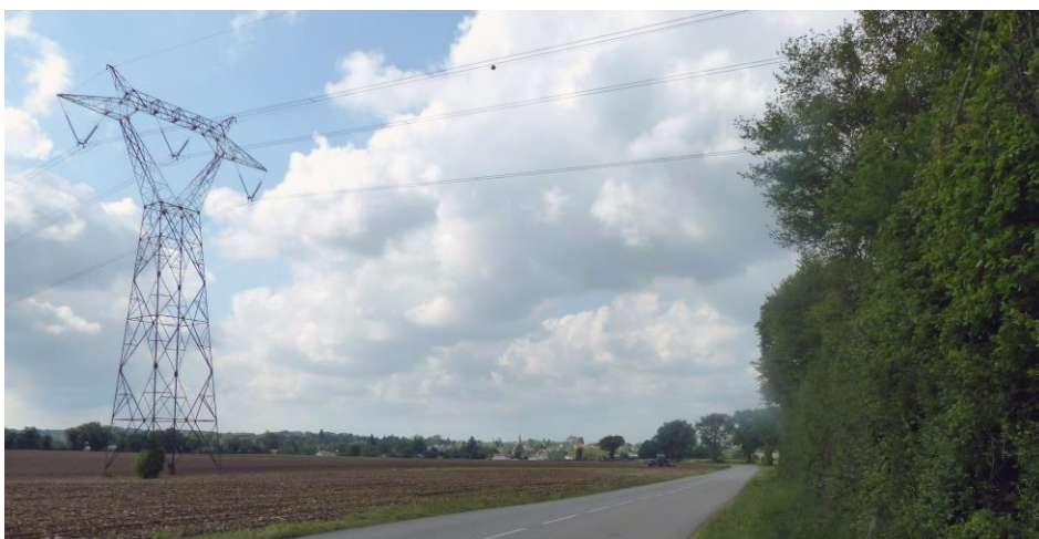
Ligne THT traversant la commune
