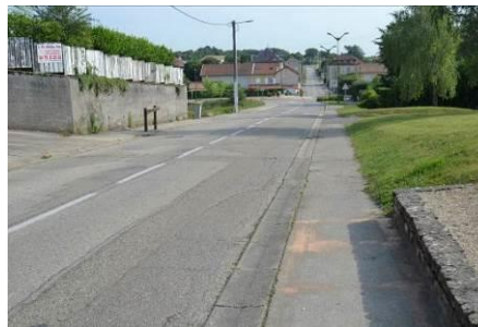
trottoirs sur la RD517a
