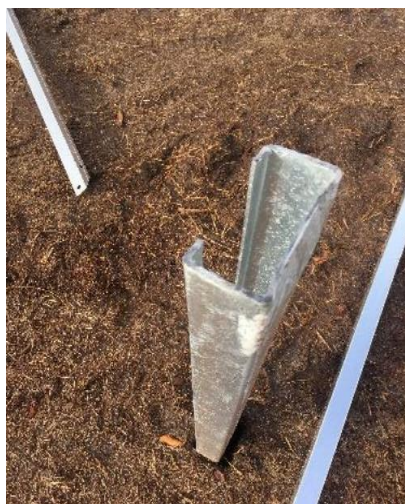
Photo : Exemple de pieu battu pour support des structures photovoltaïques
