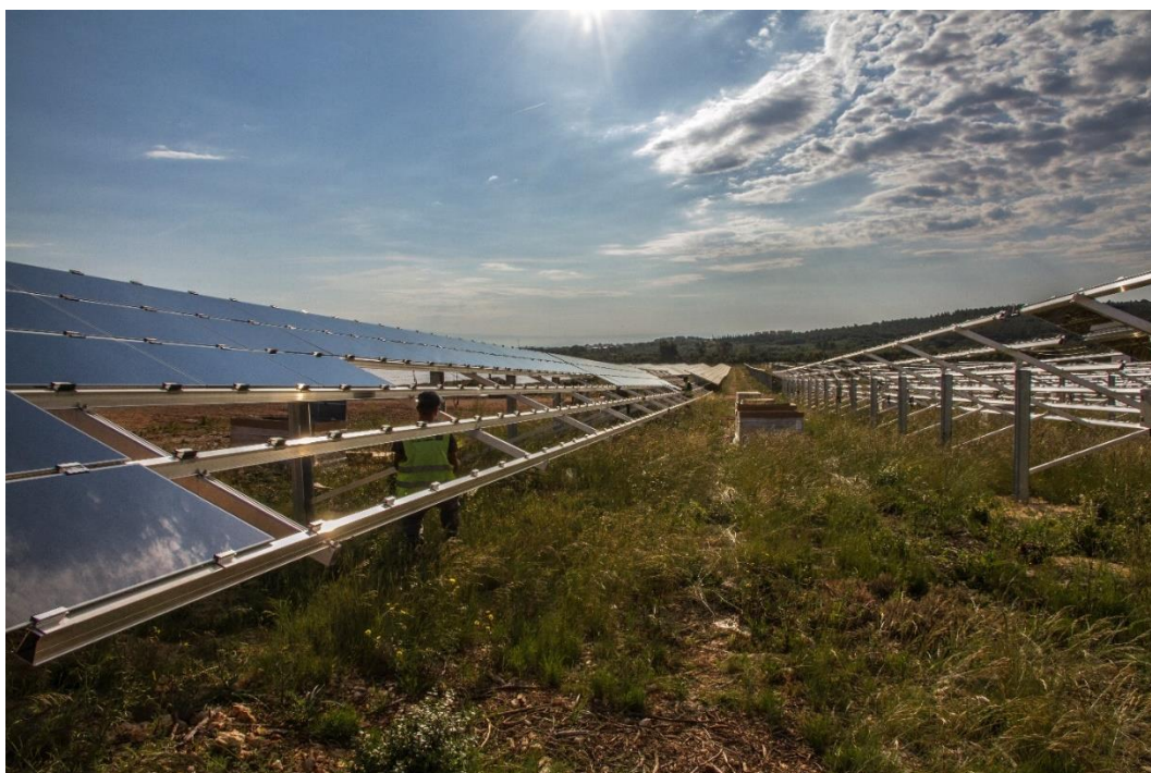
Figure : Photo d'une centrale solaire
