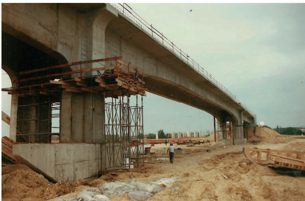
Pont de la route du « Creux » en voie de finition
