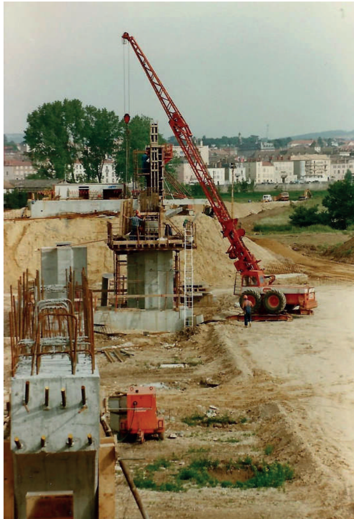
Le pont de la route de Grièges sort de terre
