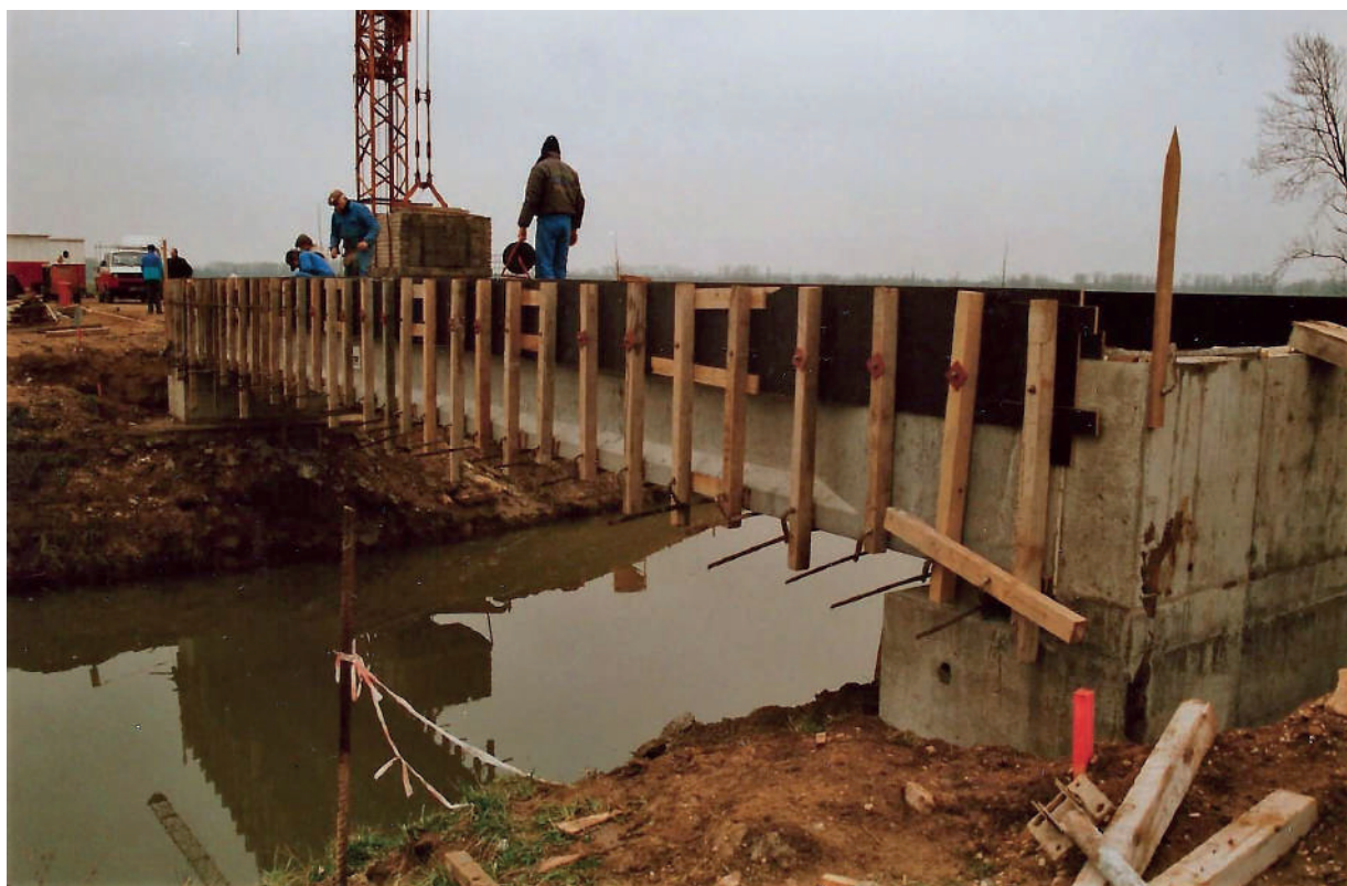
Dernier ouvrage d'art réalisé : il s'agit du pont qui enjambe La Veyle peu avant son embouchure sur le canal (janvier 1992)
