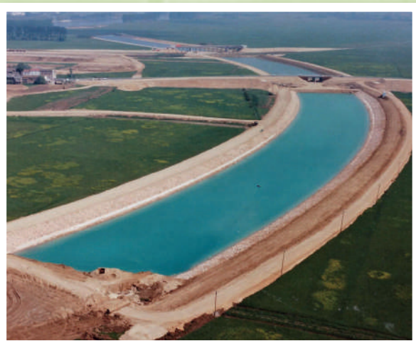
Canal de dérivation de la Saône en construction (1991)
