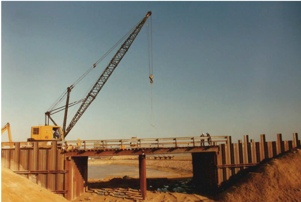
Pont provisoire de la dérivation de la « Levée »
