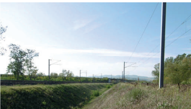
BIFURCATION LYON-PONT DE VEYLE AU SORTIR DU VIADUC DE LA SAONE
