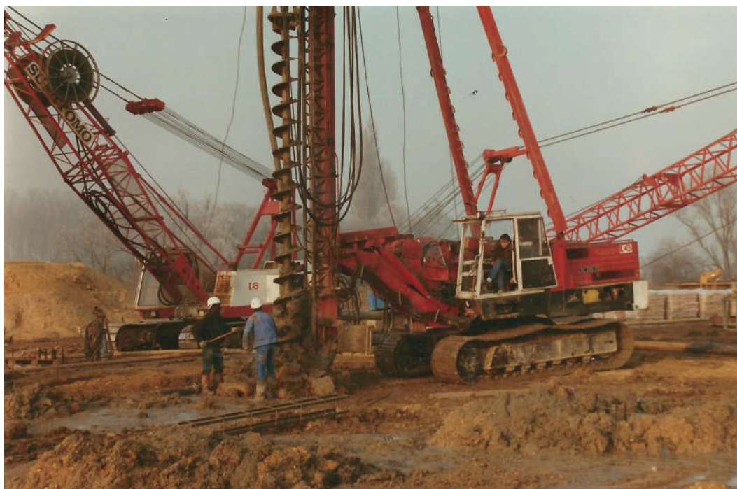
Travaux de forage des pieux devant supporter les piles du pont
