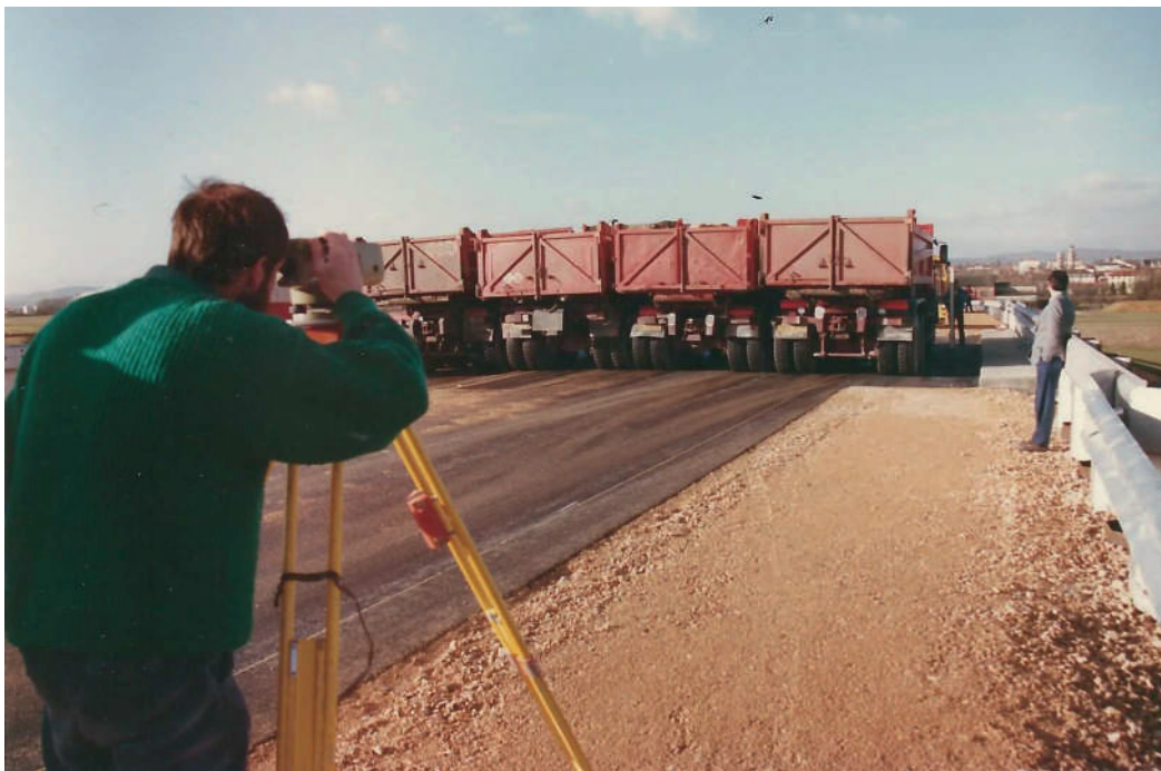
Test de charge du pont provisoire
