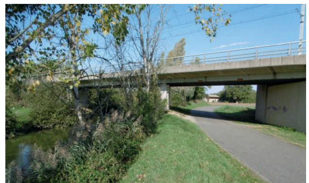
PONT RAIL « Chavannes » (Passage VC3 et la rivière La Veyle)
