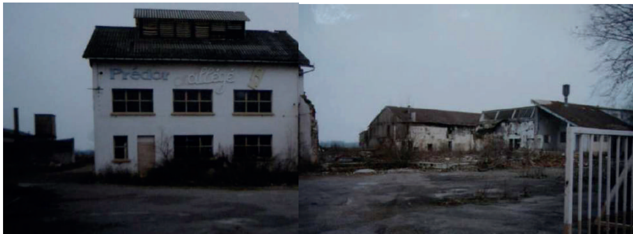
L'usine abandonnée pendant sa démolition
