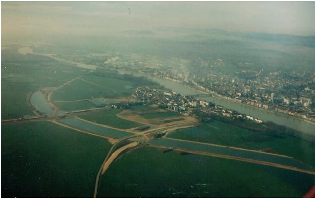
Vue aérienne du chantier en mars 1989 ; au centre le dépôt des matériaux extraits qui constituera la zone remblayée
