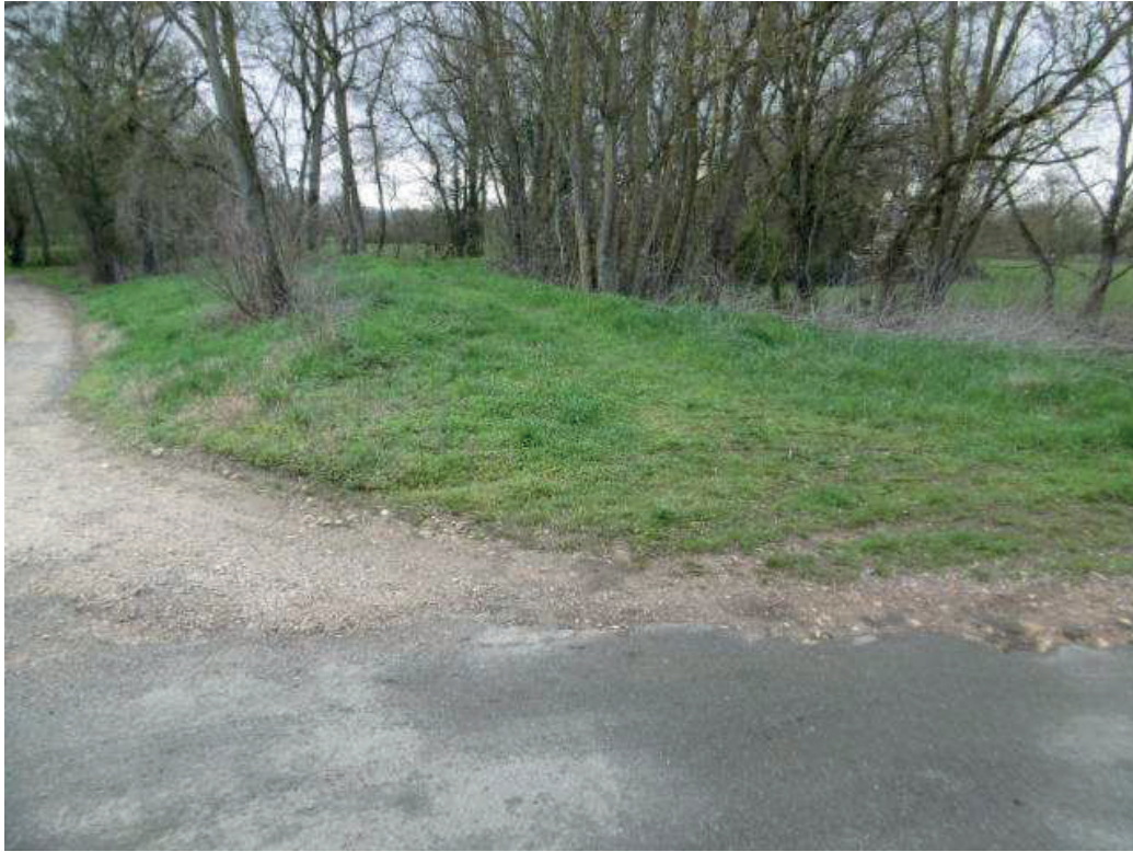
EXTREMITE SUD DE LA DIGUE Hameau de « Chavannes »
