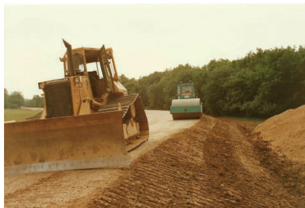
Construction de la digue latérale à la ligne de chemin de fer et à la Veyle
