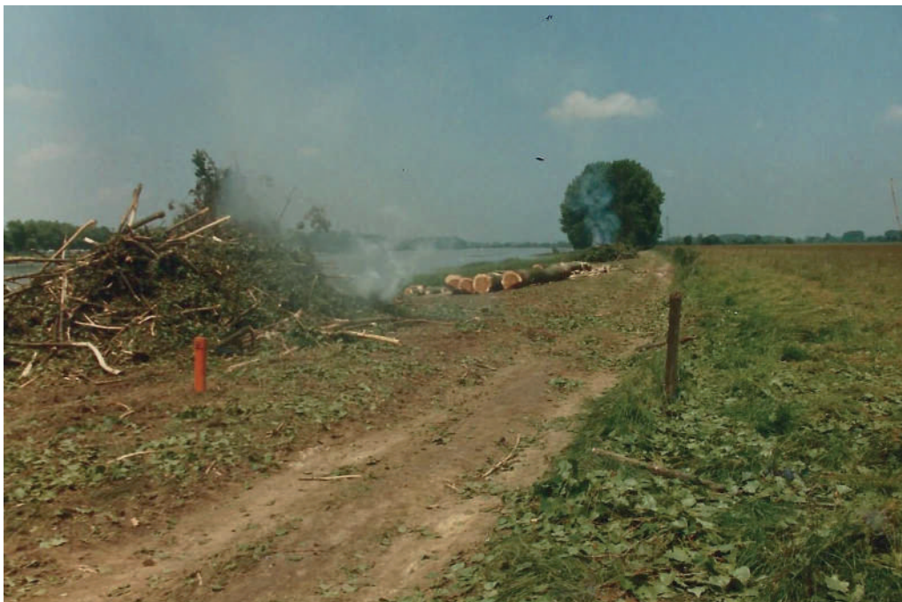
Travaux de déboisement au nord de SAINT LAURENT-SUR-SAONE
