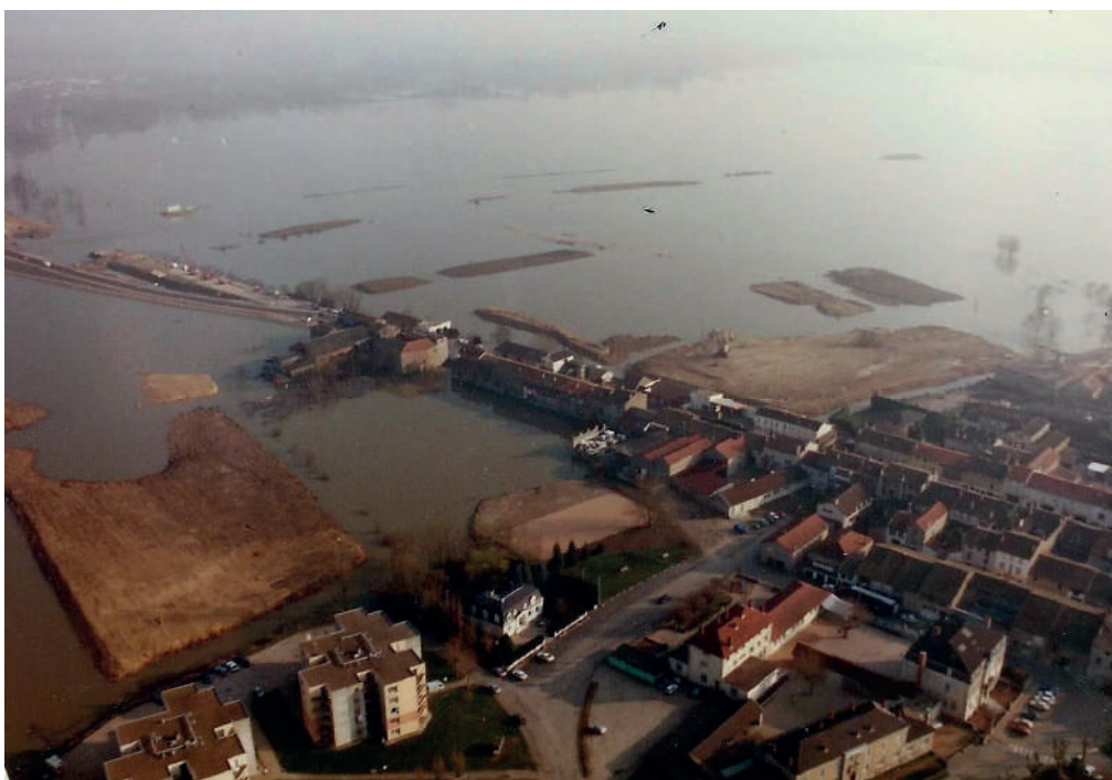
Vue de SAINT LAURENT SUR SAONE le 22 février 1991 ; le chantier est bel et bien à l'arrêt...
