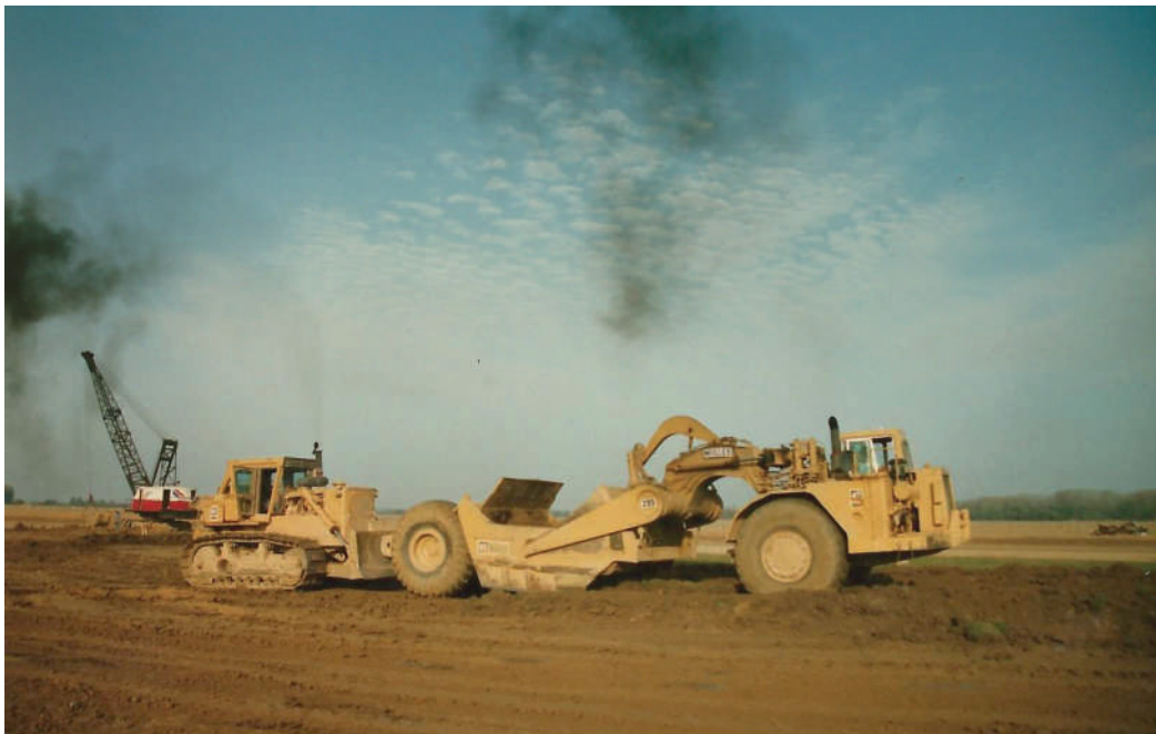
Travaux de décapage (scraper poussé par un bulldozer)
