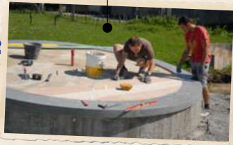
Pose du dallage
