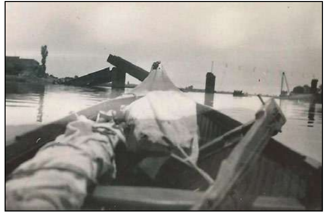
Démolition du pont par les membres Du Club de plongée de Mâcon
