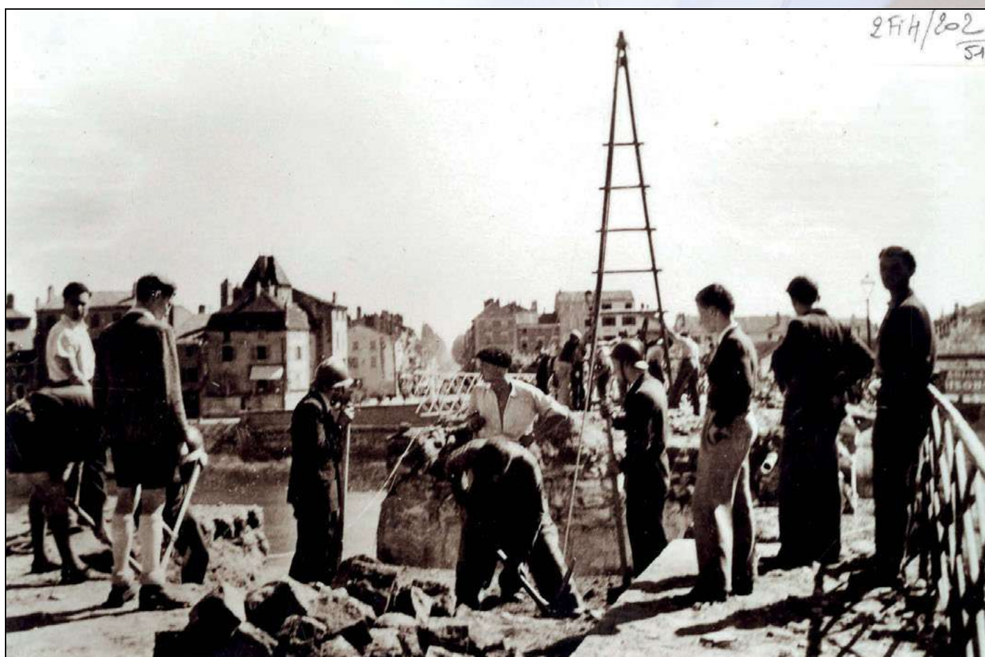
Début des travaux de réparation dès le lendemain
