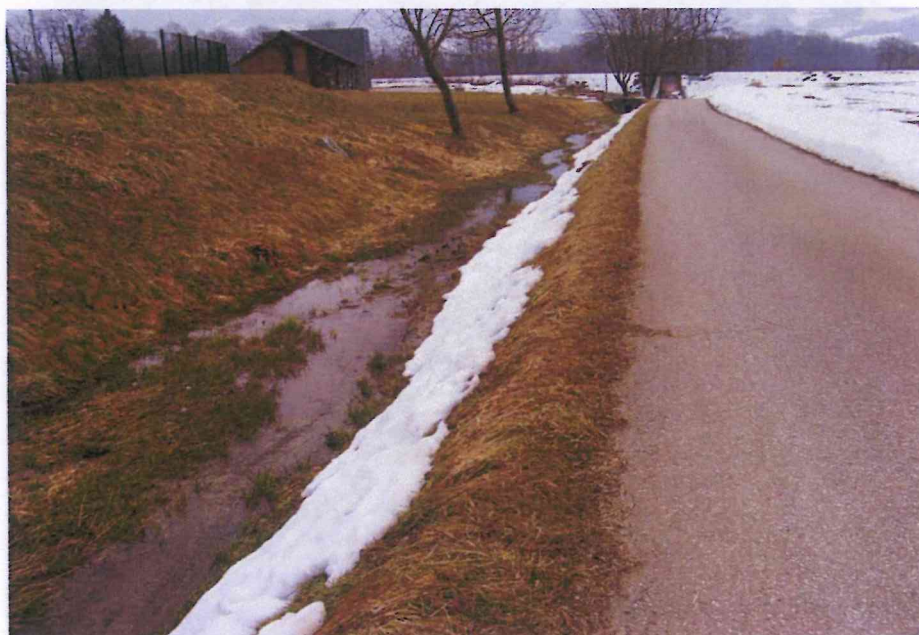
Illustration 6: Fossé d'évacuation des eaux pluviales - chemin du Crozattet
