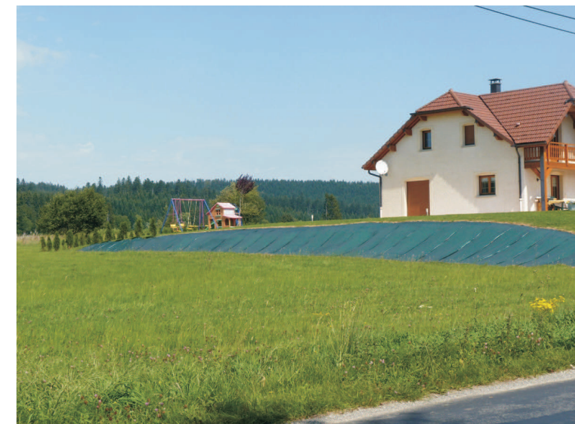
Construction sur remblai en zone humide (Les Seignes)
