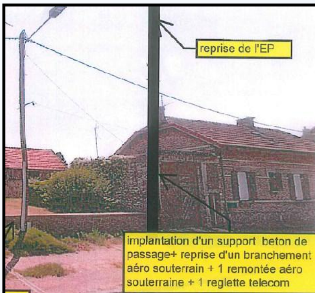
Dépose du support béton
